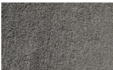
2.5.a : Walls External
