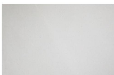
4.5.b : WALLS - INTERNAL
