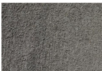
5.5.a : WALLS - EXTERNAL
